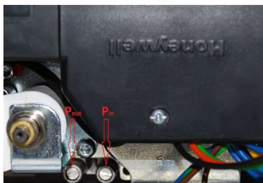
Zdjęcie 21 - Króćce pomiaru ciśnienia gazu
